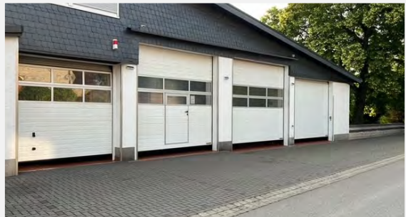
Werkstattgebäude „An der Grube“ 5
