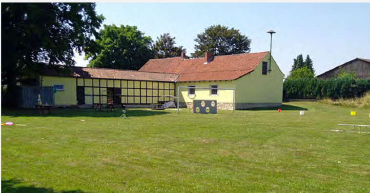
Die Rückseite des Dorfgemeinschaftshauses mit neuem Anstrich!
