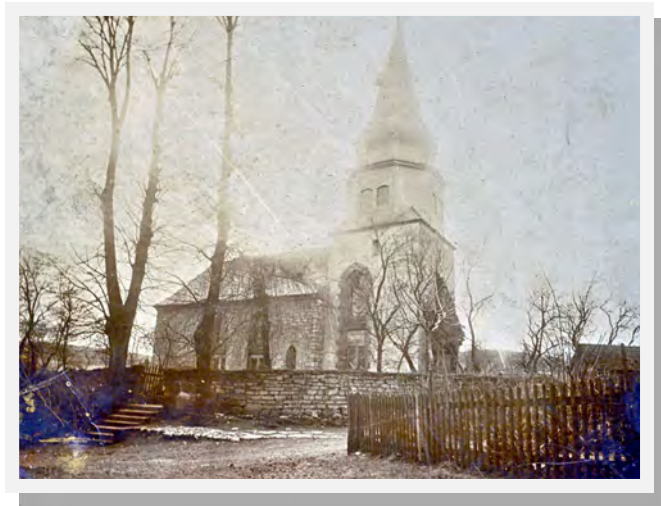
Die Kirche im Jahre 1900 mit der alten Friedhofsmauer
