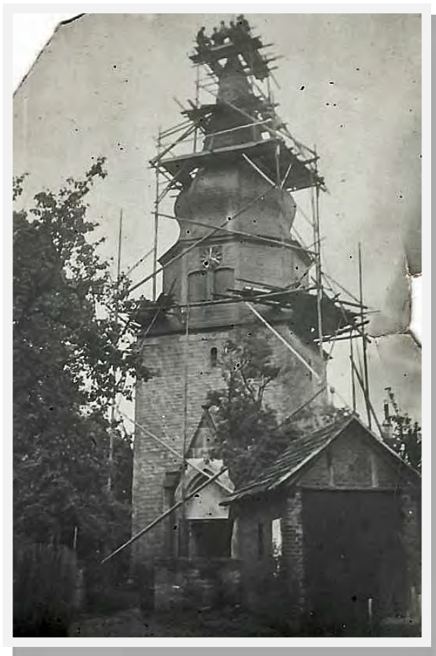
Von H. Kropp in Netze wurden die Dachdeckerarbeiten und die Reparaturarbeiten an der Orgel von der Firma Becker Hannover ausgeführt.
