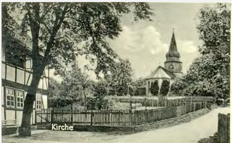
Ein Blick zur Kirche. Heute leider verbaut!
